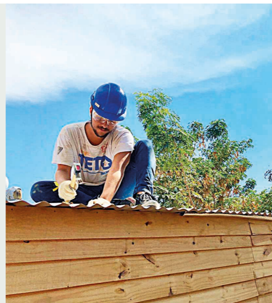
No final da construção, os alunos entregaram a Alex o álbum com as fotos da construção de sua casa
